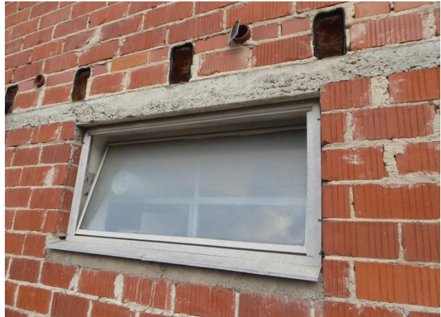
Abbildung 3: Einflugmöglichkeit in das Gebäude
