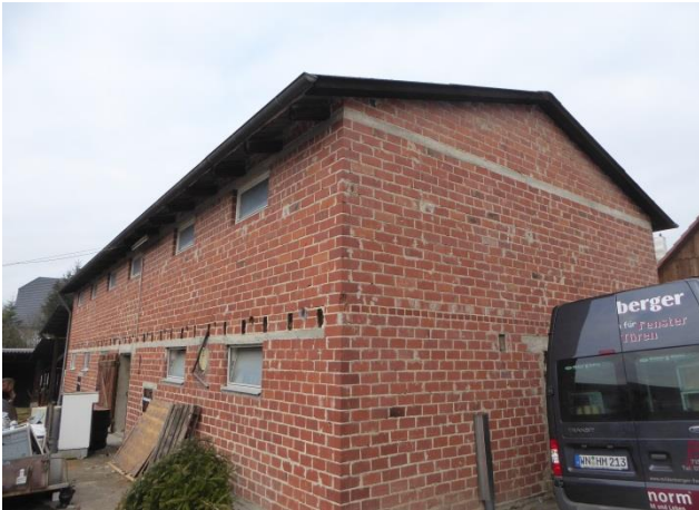
Abbildung 2: Blick auf das untersuchte Gebäude
