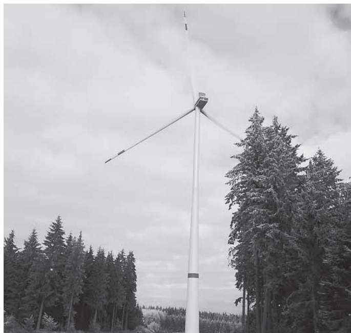
Windrad in Hoßkirch Typ Vestas 162-6.2 MW™ Nabenhöhe 175 m Foto: privat
